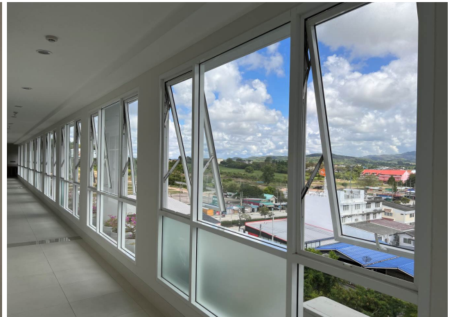
ภาพที่ 1-25 ระบบระบายอากาศของโครงการ
