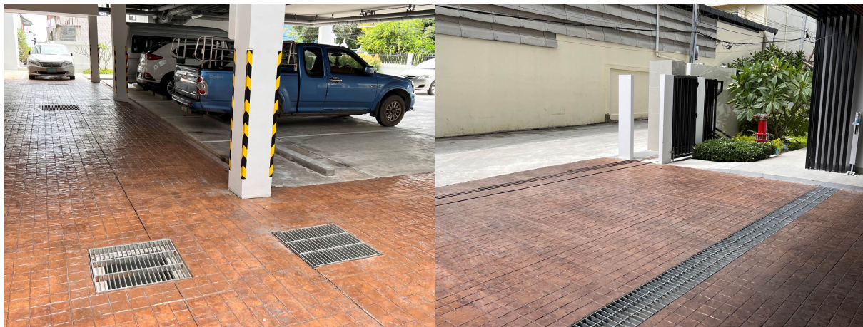
ภาพที่ 1-9 ระบบระบายน้ำฝนของโครงการ
