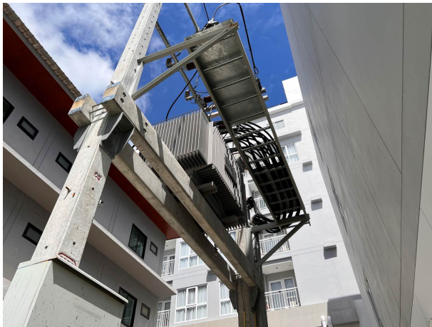
ภาพที่ 1-12 หม้อแปลงไฟฟ้าของโครงการ
